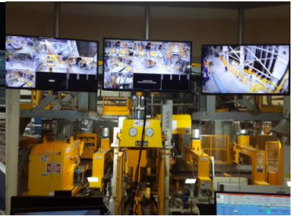
Tat Metal 2. Galvenizleme Tesisi
